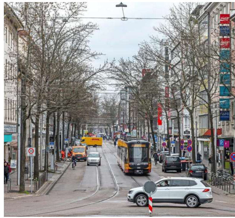
Neugestaltung kommt: Im nächsten Jahr beginnt am Kaiserplatz der Bau einer neuen Straßenbahnhaltestelle. Foto: Müller-Gmelin
